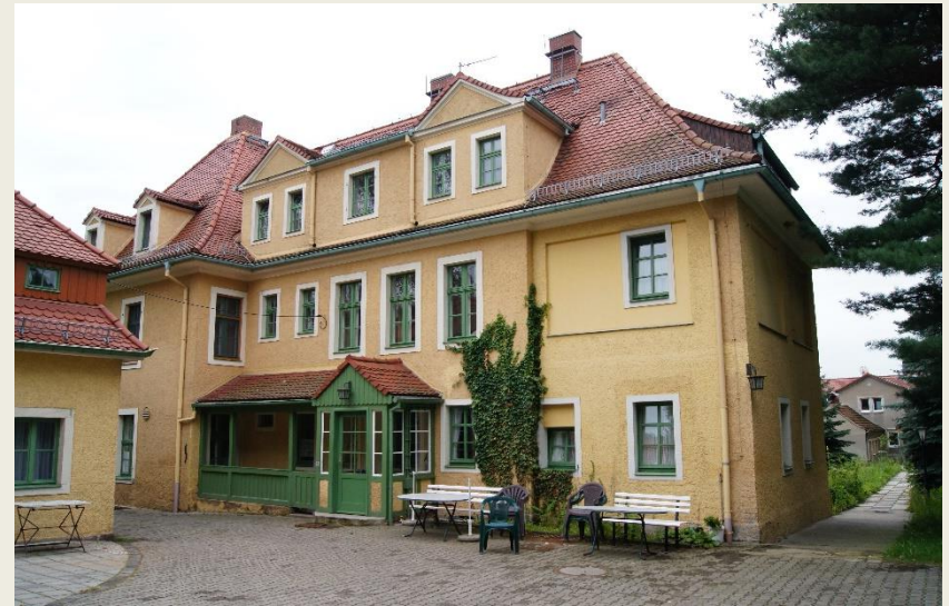
Wohnhaus Winzerstraße 22, Radebeul, Sachsen, Zustand 2016, Foto MM+H
